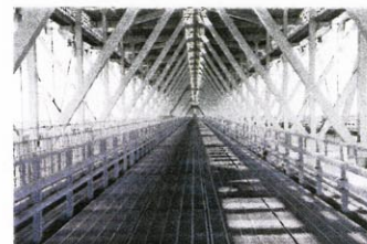
橋桁内の管理路
